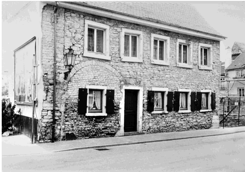
Fotoaufnahme von 1984 der noch unsanierten Westfassade des Tor- wärterhauses (Urheber unbekannter)
